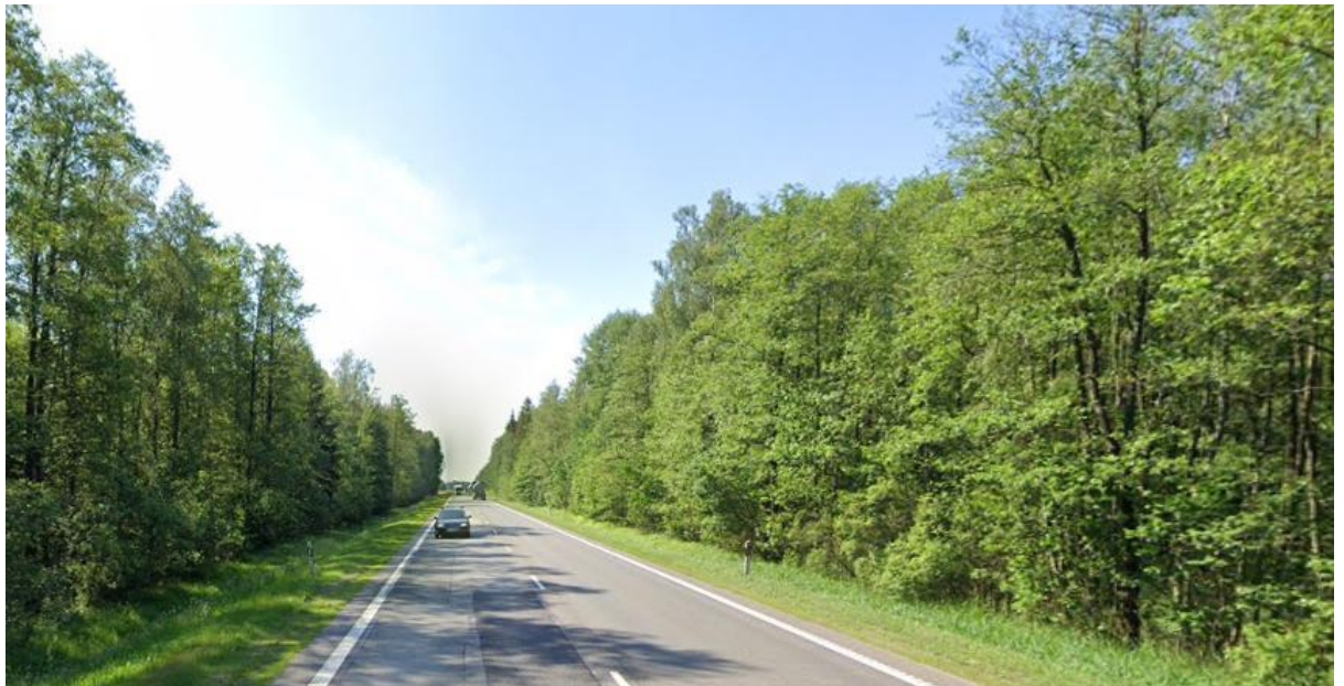
44 pav. Miškų teritorijos abipus kelio ties 58,65 km. Želdiniai patenka į esamą kelio A8 sklypą, ir miškų plotus
