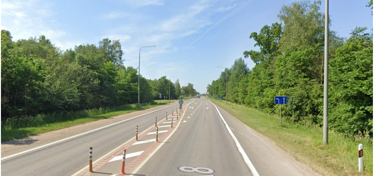
43 pav. Miškų teritorijos abipus kelio ties 53,7 km. Želdiniai patenka į esamą kelio A8 sklypą, ir miškų plotus
