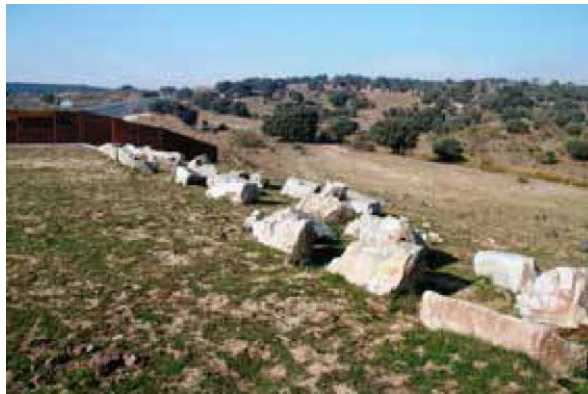
27 pav. Sistemos, kuriose naudojami rieduliai, kad būtų išvengta transporto priemonių judėjimo gyvūnams skirtuose statiniuose (pralaidos, žalieji tiltai)
