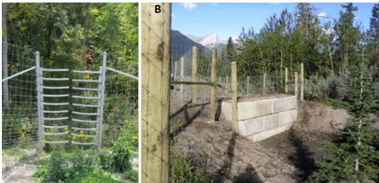
23 pav. Gyvūnų pabėgimo įrenginiai: A – vienvėriai varteliai, B – nušokimo rampa
