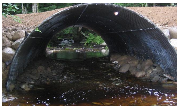
20 pav. Gofruoto plieno pralaida su natūraliu pagrindu bei iš akmenų suformuota sausesniu, bet drėgmę išlaikančiu praėjimu varliagyviams bei smulkiesiems žinduoliams
