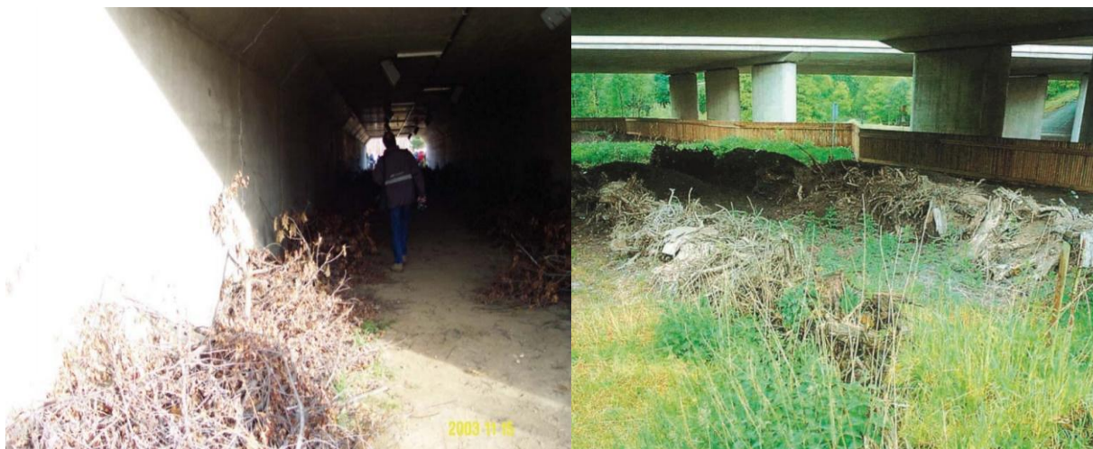
25 pav. Sausų šakų, šaknų, rastų, akmenų ar kitų natūralių objektų išdėstymas pralaidose suteikia slėptuves gyvūnams (šaltinis Potenciano et al. 2016)
