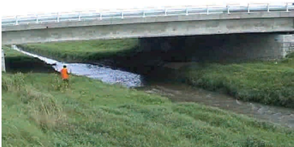
34 pav. Tiltas per upę paliekant vietos gyvūnų migracijai krantu (gyvūnų perėja po tiltu)
