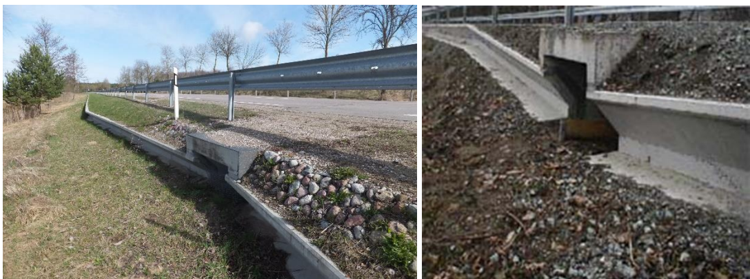
13 pav. Gelžbetoninės C – formos tvorelės su pralaida įrengimo pavyzdžiai
